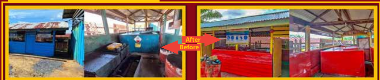
Gambar 8. Kondisi Collecting Point PT Bhumi Simanggaris Indah Sebelum dan Sesudah Perbaikan
